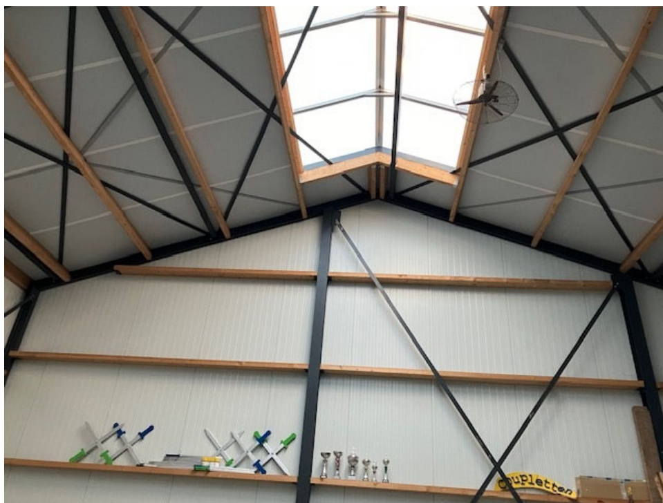
• Afbeelding 21: binnenzijde loods (blijft behouden)
