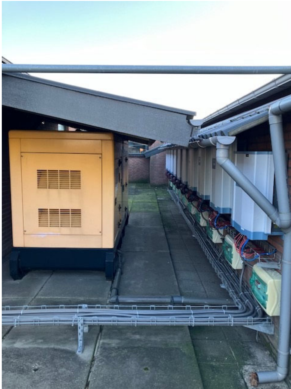
• Afbeelding 8: Aggregaat en locatie omvormers zonnepanelen
