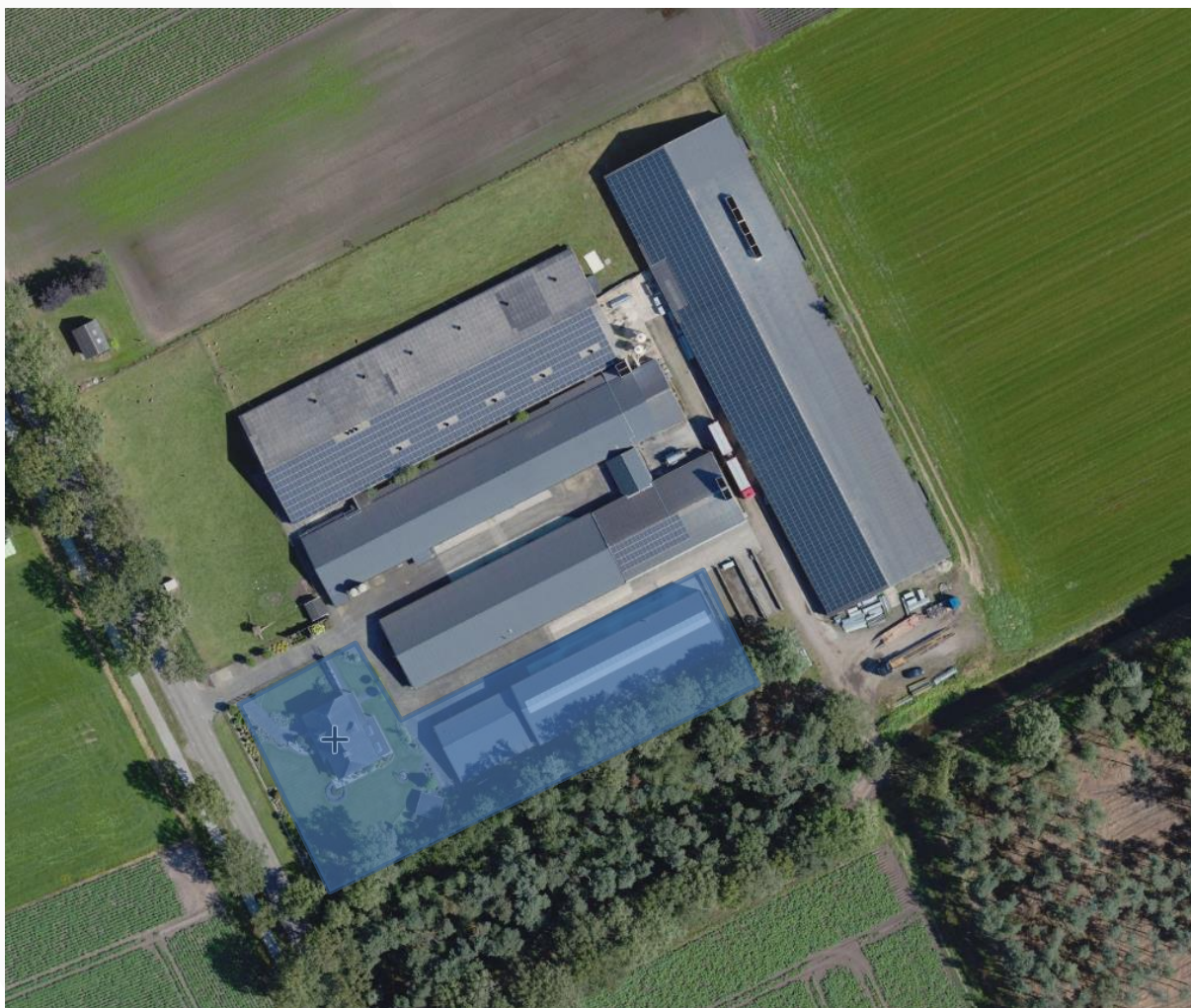
Figuur 2.1.1: luchtfoto locatie Sterkselseweg 2024; blauw gearceerd locatie te behouden bebouwing (bron: streetsmart.cyclomedia.com).
