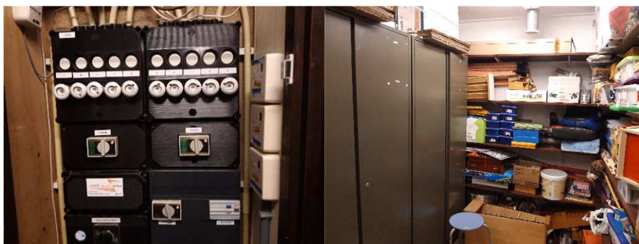
Bergingsruimte, meterkast en opslagplaats.
